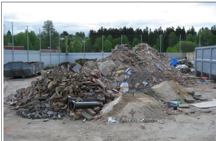
Obrázek 16 – Stavební a demoliční odpad – ilustrační foto
