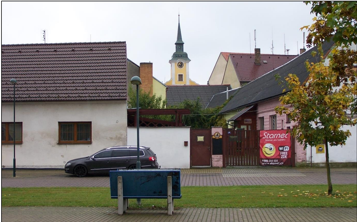
Obr. 3: Ilustrační foto – kompoziční osa (průhled) v Lomnici nad Lužnicí (příklad kompoziční osy v zastavěném území)
