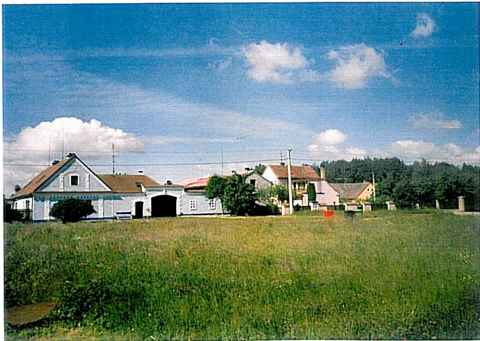
Fotodokumentace: nevhodné úpravy
